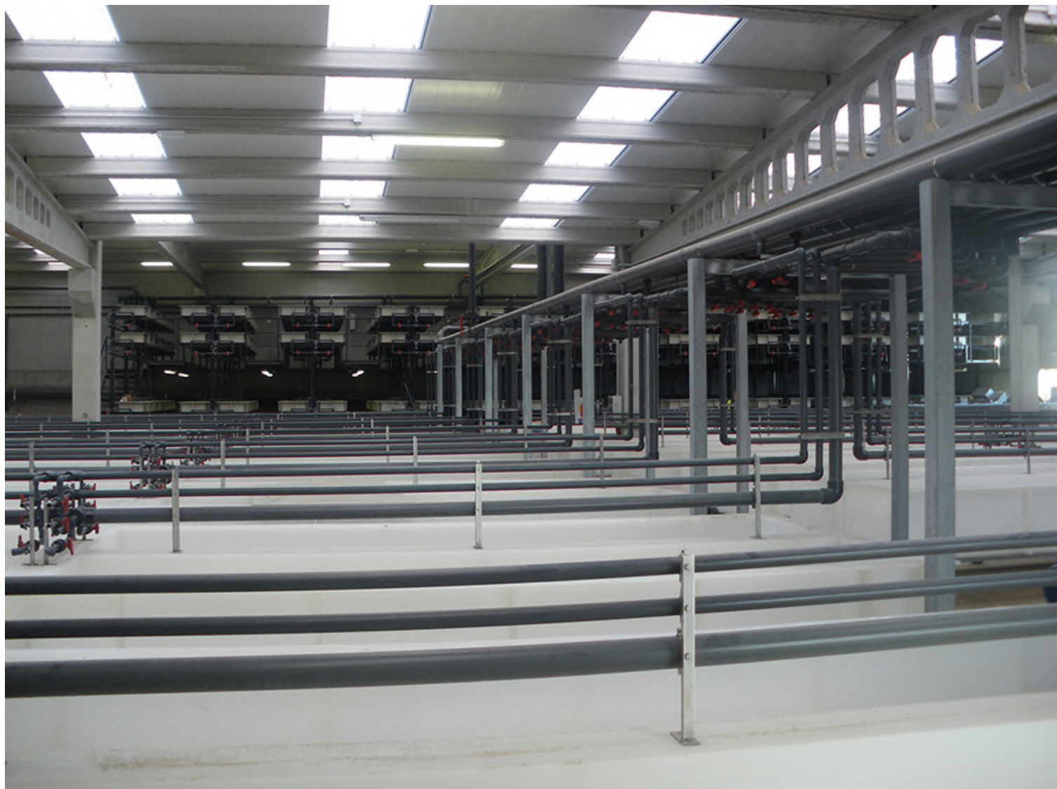
CONSTRUCCIÓN DE GRANJA MARINA Y NAVE INDUSTRIAL PARA CULTIVO DE ABALÓN EN A PIELA. MUROS. A CORUÑA
