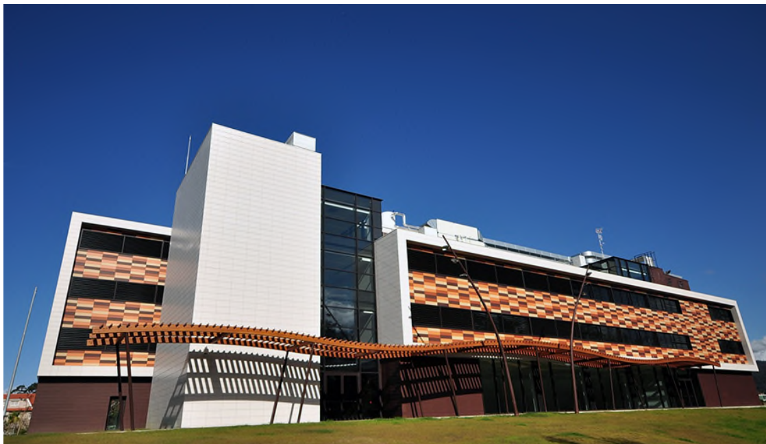
CONSTRUCCIÓN DE EDIFICIO TECNOLÓGICO DE OFICINAS PARQUE EMPRESARIAL PORTO DO MOLLE. NIGRÁN. PONTEVEDRA
