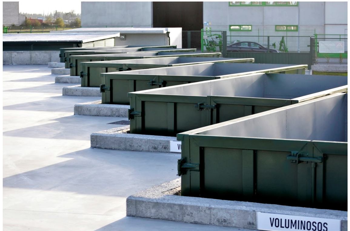
CONSTRUCCIÓN DE PUNTO LIMPIO EN OUTEIRO DE REI, LUGO
