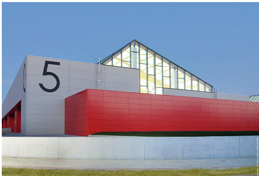
CONSTRUCCIÓN DE 10 NAVES BIOCLIMÁTICAS EN HILERA PARQUE EMPRESARIAL PORTO DO MOLLE. NIGRÁN. PONTEVEDRA (UTE)
