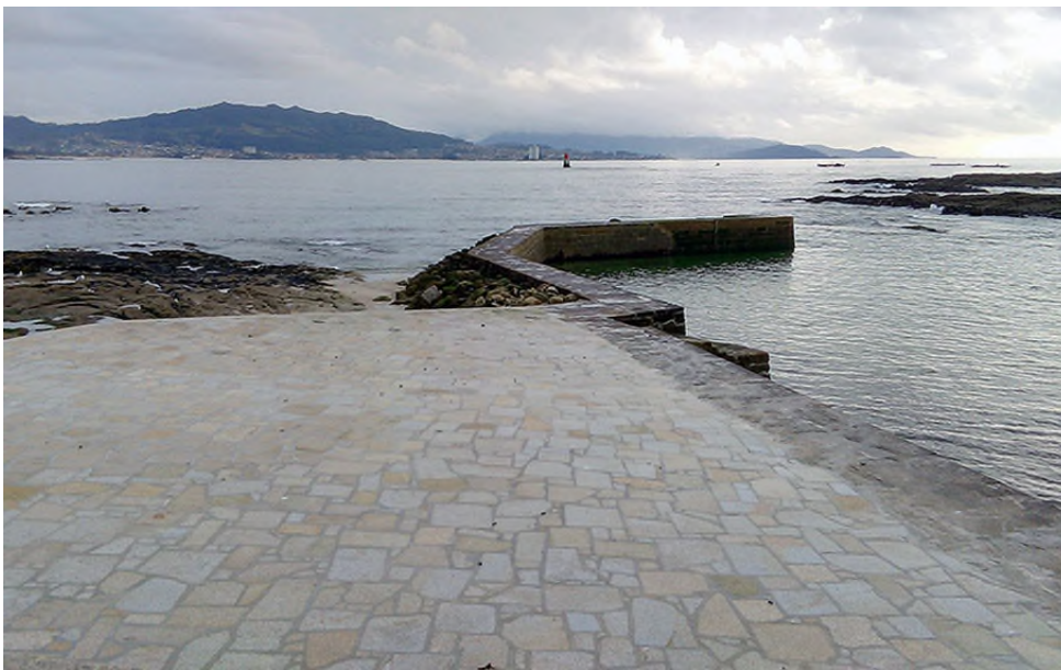
REFORMA DEL MUELLE DE CONGORZA. CANGAS. A CORUÑA
