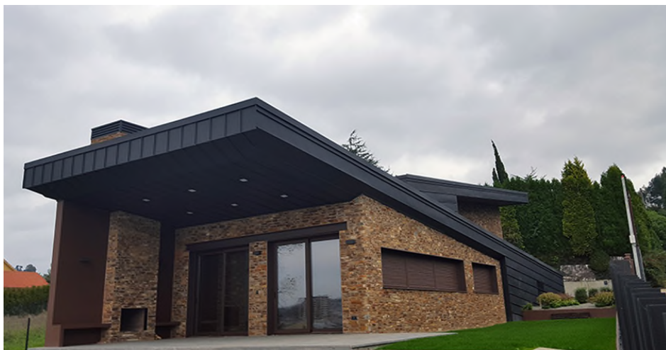
VIVIENDA UNIFAMILIAR AISLADA CON PISCINA EN OLEIROS. A CORUÑA
