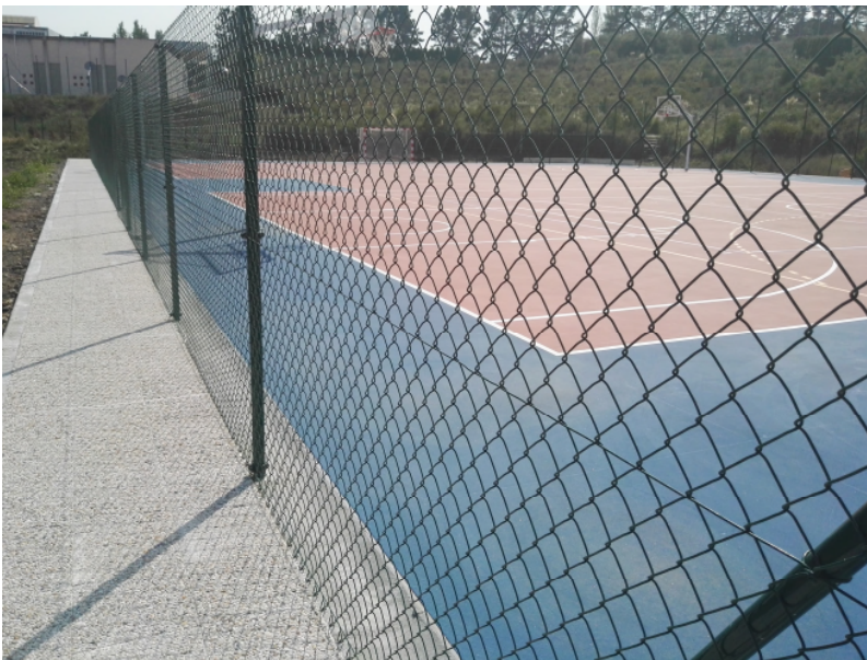
URBANIZACION EN TORNO A LA PISTA DEPORTIVA COLEGIO "MONTESPIÑO". CULLEREDO. A CORUÑA
