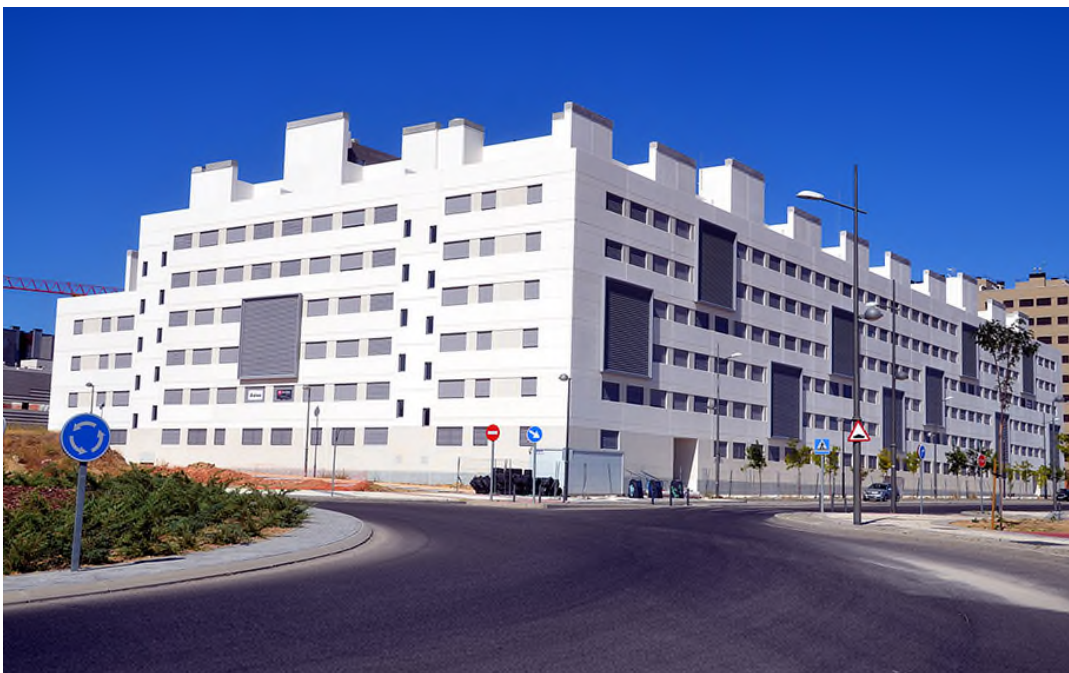
EDIFICIO DE 250 VIVIENDAS VPPA CON GARAJES Y TRASTEROS EN EL PAU 4 "MOSTOLES SUR". MADRID (UTE)
