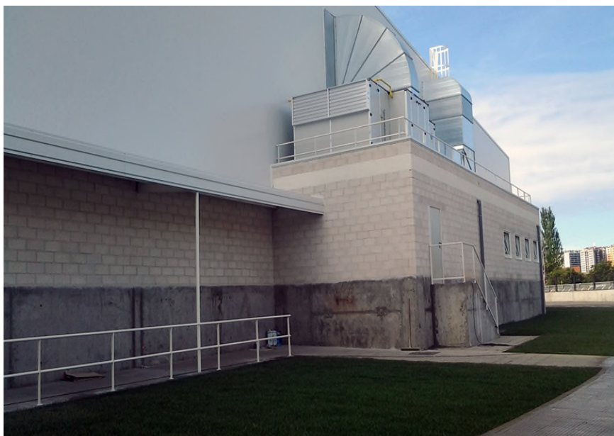
CONSTRUCCIÓN DE NAVE INDUSTRIAL Y MEJORA DE VIALES NAVE "G" EN POLÍGONO INDUSTRIAL DE BALAIÓDOS. VIGO. PONTEVEDRA
