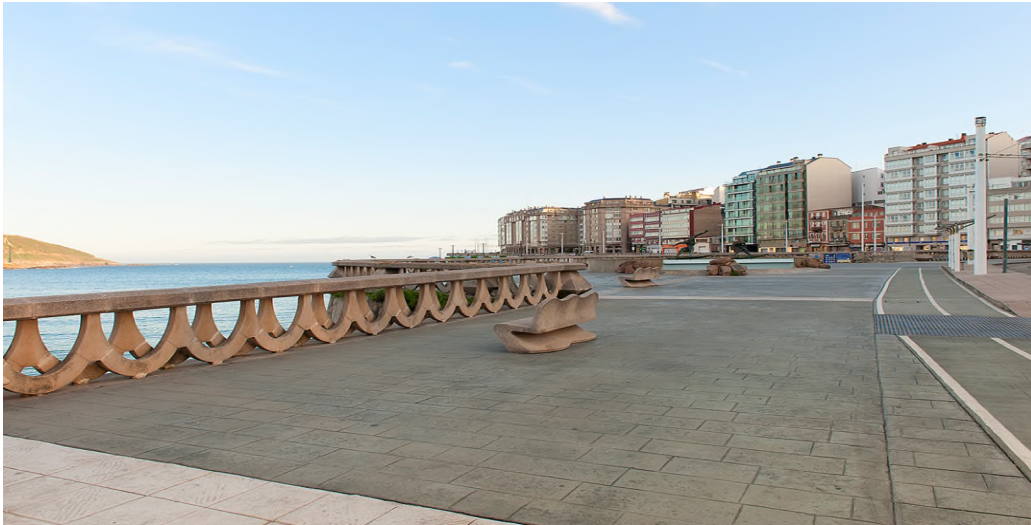
CONSTRUCCIÓN DE ACERA Y CARRIL BICI EN PASEO MARÍTIMO ZONA SALESIANOS. A CORUÑA
