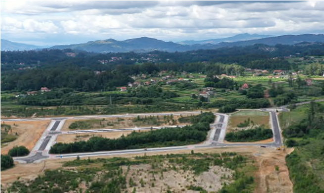
OBRAS DE URBANIZACIÓN DEL ÁREA LOGÍSTICA EMPRESARIAL (LE) EN LA PLISAN, (2ª FASE). VIGO
